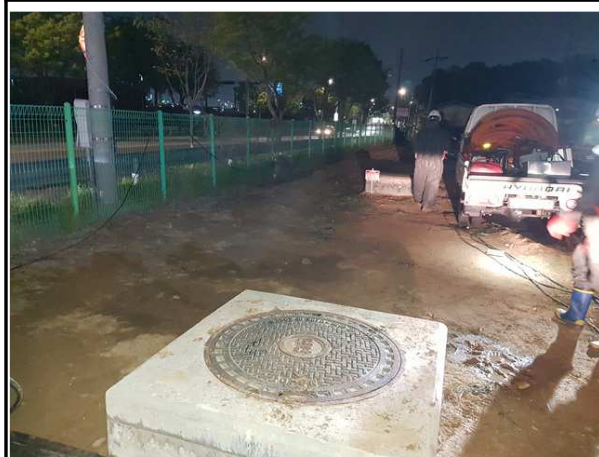
내용 맨홀 외부 전경 상태양호
