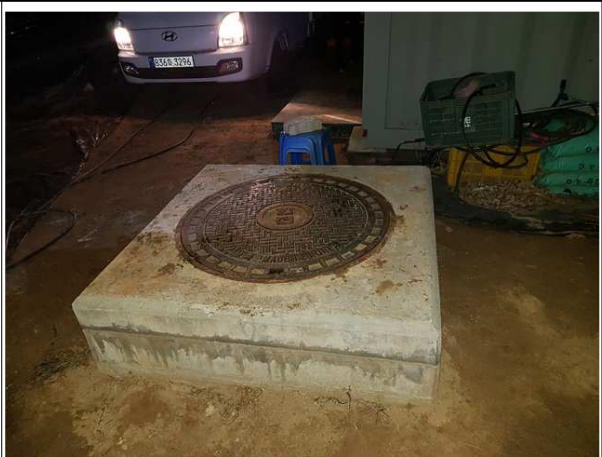
내용 맨홀 상부 상태양호
